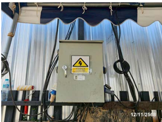
รูปที่ 2-28 แผงควบคุมไฟ
