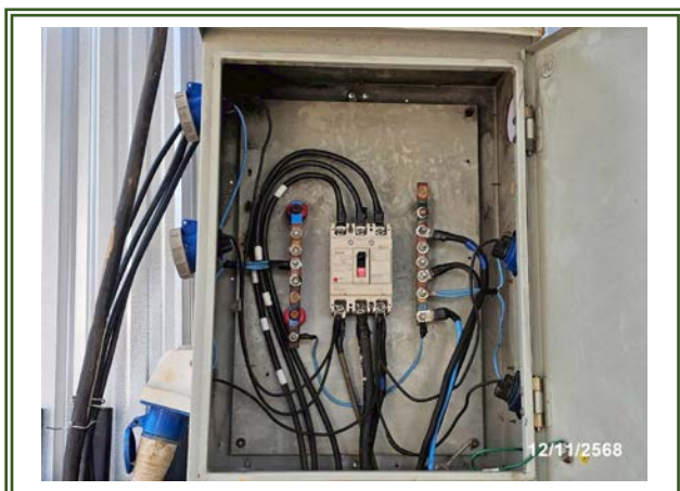
รูปที่ 2-34 สวิตช์ตัดวงจรไฟฟ้า
